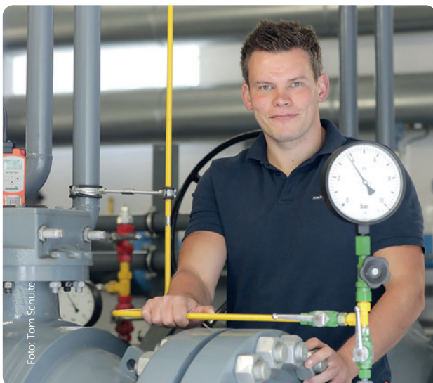
Techniker Anton Hoff kümmert sich um die Instandhaltung der Erdgas-Anlagen.
